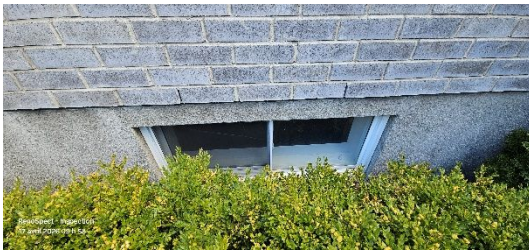
Terrassements et aménagements Présence d'arbres Façade arrière
