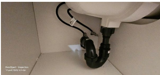
Conduits d'évacuation (ABS) Sans anomalie importante Lavabo
