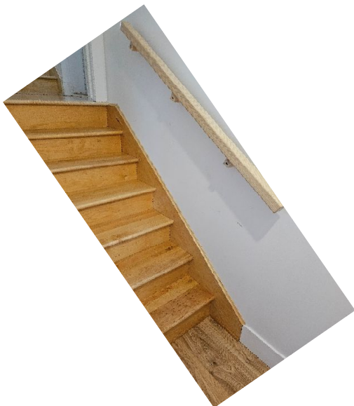
Escaliers intérieurs Sans anomalie importante Vers 1 er étage
