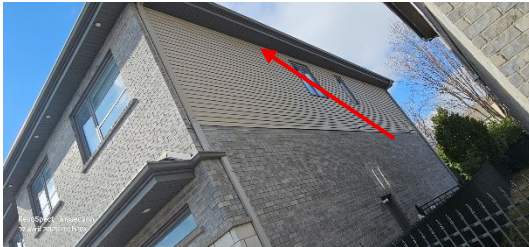
Clin d'aluminium Déformation Côté droit
