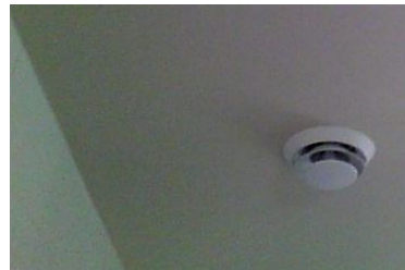
VRC – Ventilateur de plafond Sans anomalie importante Salle de bain
