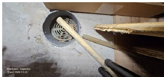
Drain de plancher Sans anomalie importante (Chambre mécanique)
