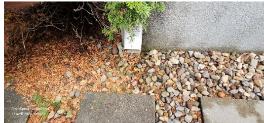
Descentes pluviales Drainage à proximité des fondations Côté gauche
