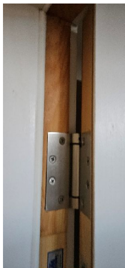
Mur mitoyen du garage – Porte Sans anomalie importante Garage
