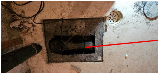
Fosse de retenue – Drain gravitaire Sans anomalie importante Chambre froide
