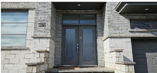
Porte d'entrée Sans anomalie importante Façade avant
