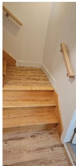
Escaliers intérieurs Sans anomalie importante Sous-sol
