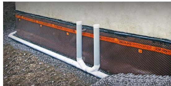
Exemple - Membrane Delta MS Installation typique
