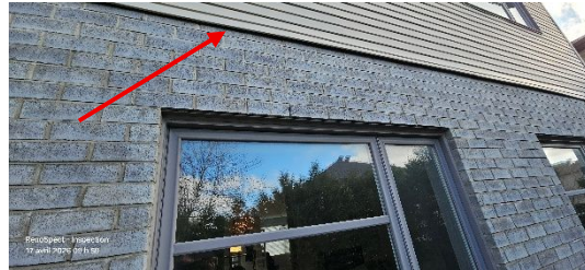
Clin d'aluminium Bande de départ Façade arrière
