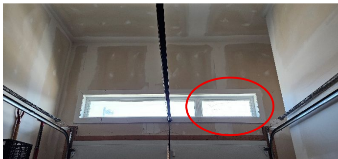
Fenêtres intérieures Bris de verre thermos Garage
