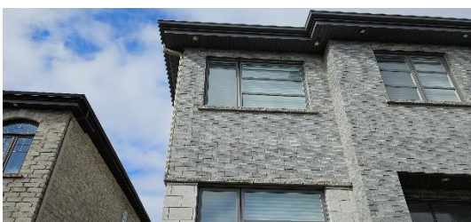
Fenêtres extérieures Sans anomalie importante Façade avant
