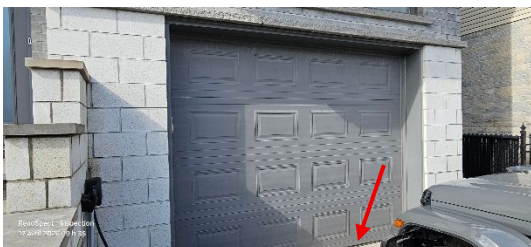
Porte de garage – Entretien (Coupe-bises) Sans anomalie importante Façade avant
