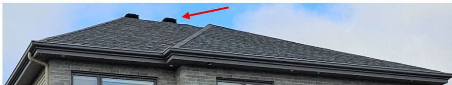
Combles - Isolation thermique et ventilation Sans anomalie importante
