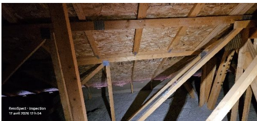
Combles - Isolation thermique et ventilation Sans anomalie importante
