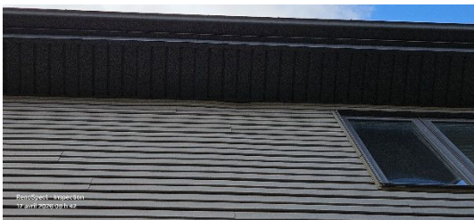
Soffites Sans anomalie importante Façade arrière
