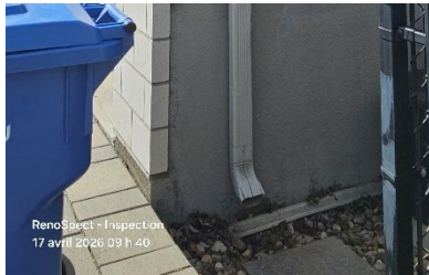
Descentes pluviales Drainage à proximité des fondations Côté droit
