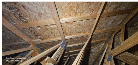
Platelage Sans anomalie importante Combles
