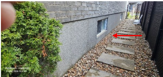
Terrassements et aménagements Pentes négatives Côté gauche
