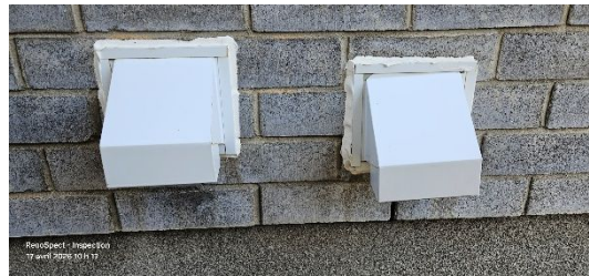
VRC – Registres extérieurs Sans anomalie importante Côté droit
