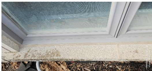
Scellant Sans anomalie importante Façade avant
