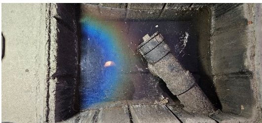
Fosse de retenue - Drain gravitaire Sans anomalie importante Garage
