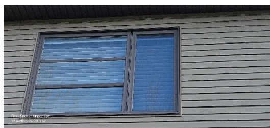
Fenêtres extérieures Sans anomalie importante Façade avant
