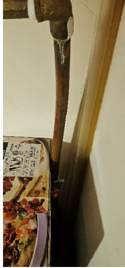
Water inlet (conduit) No major anomalies Basement
